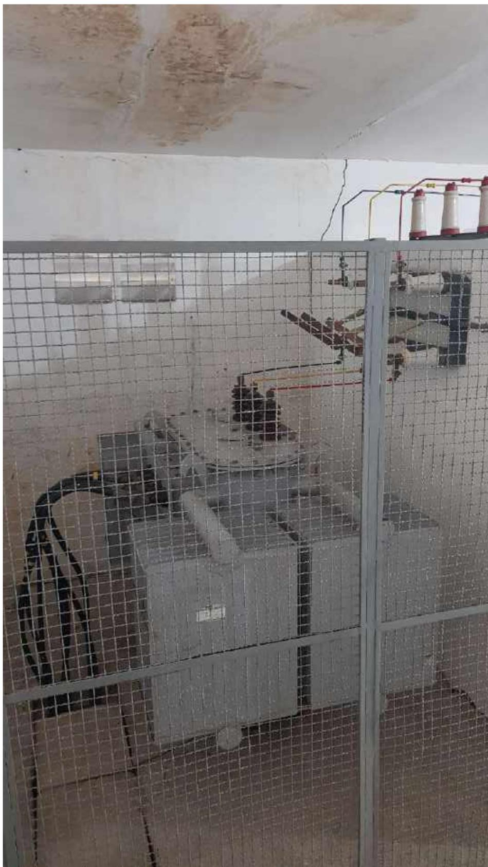
Figura 25 - Trafo de 500kvas do pav. Dunas.
