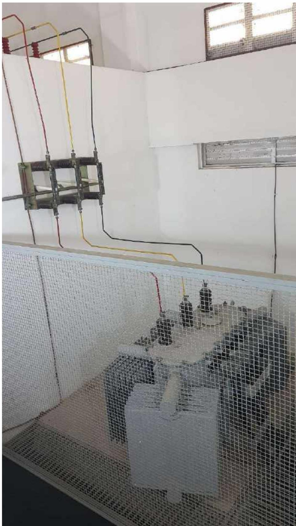
Figura 19 - Trafo de 300kvas do pav. Morton.
