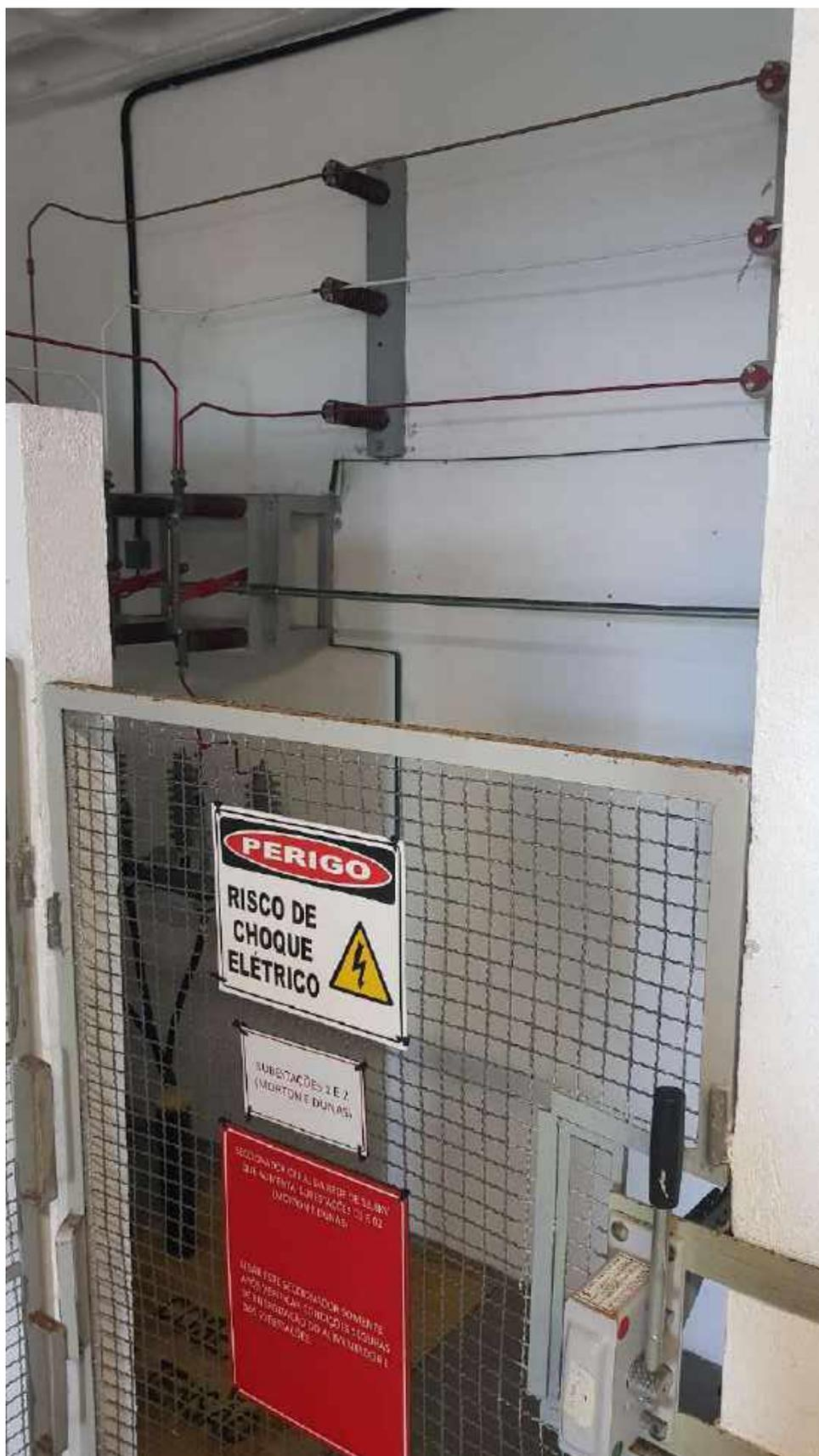
Figura 4 - Conjunto de chaves seccionadoras que originam alimentação para as subestações do Morton e Dunas.
