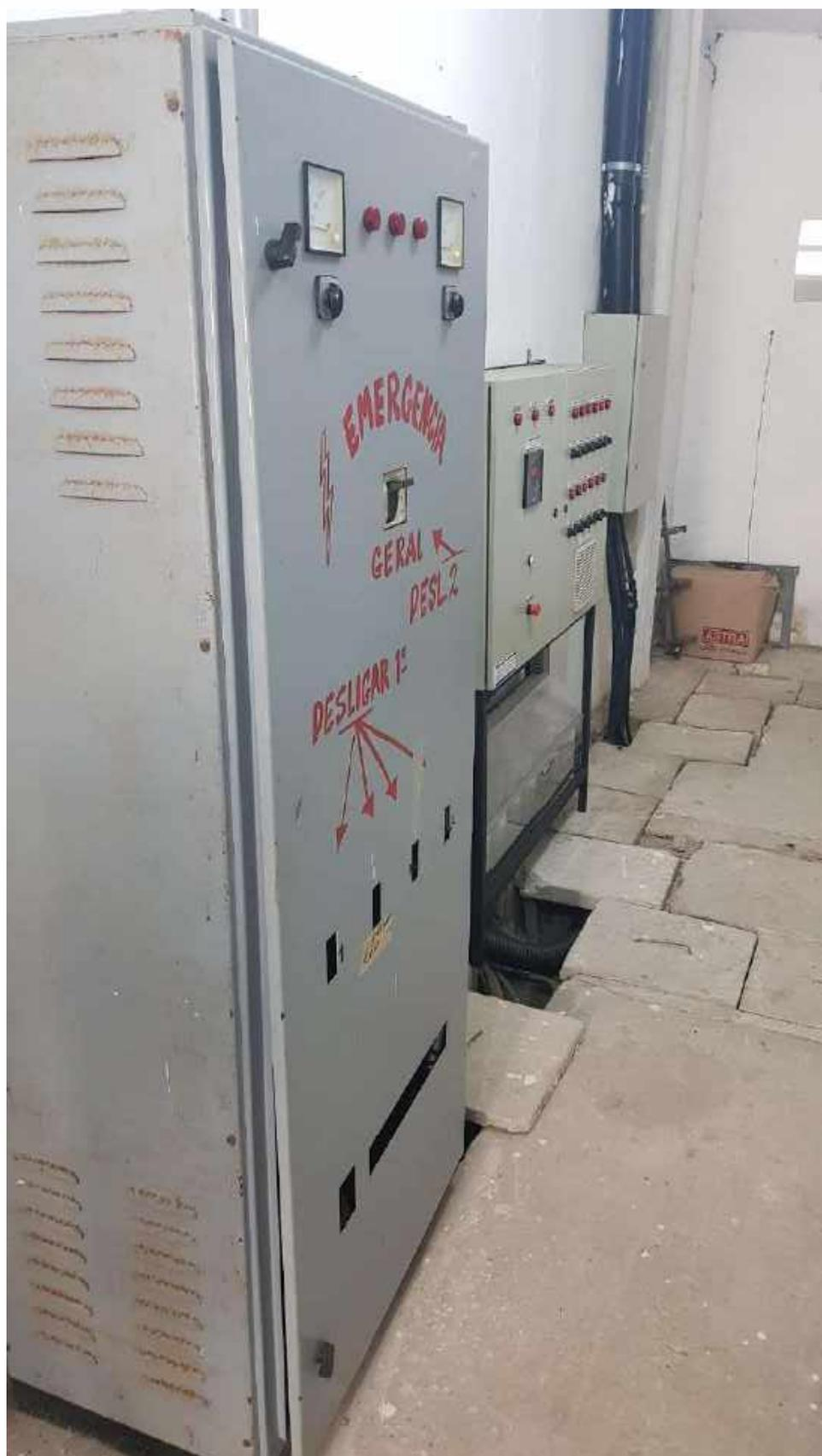
Figura 26 - QGBT da sub. do pav. Dunas.
