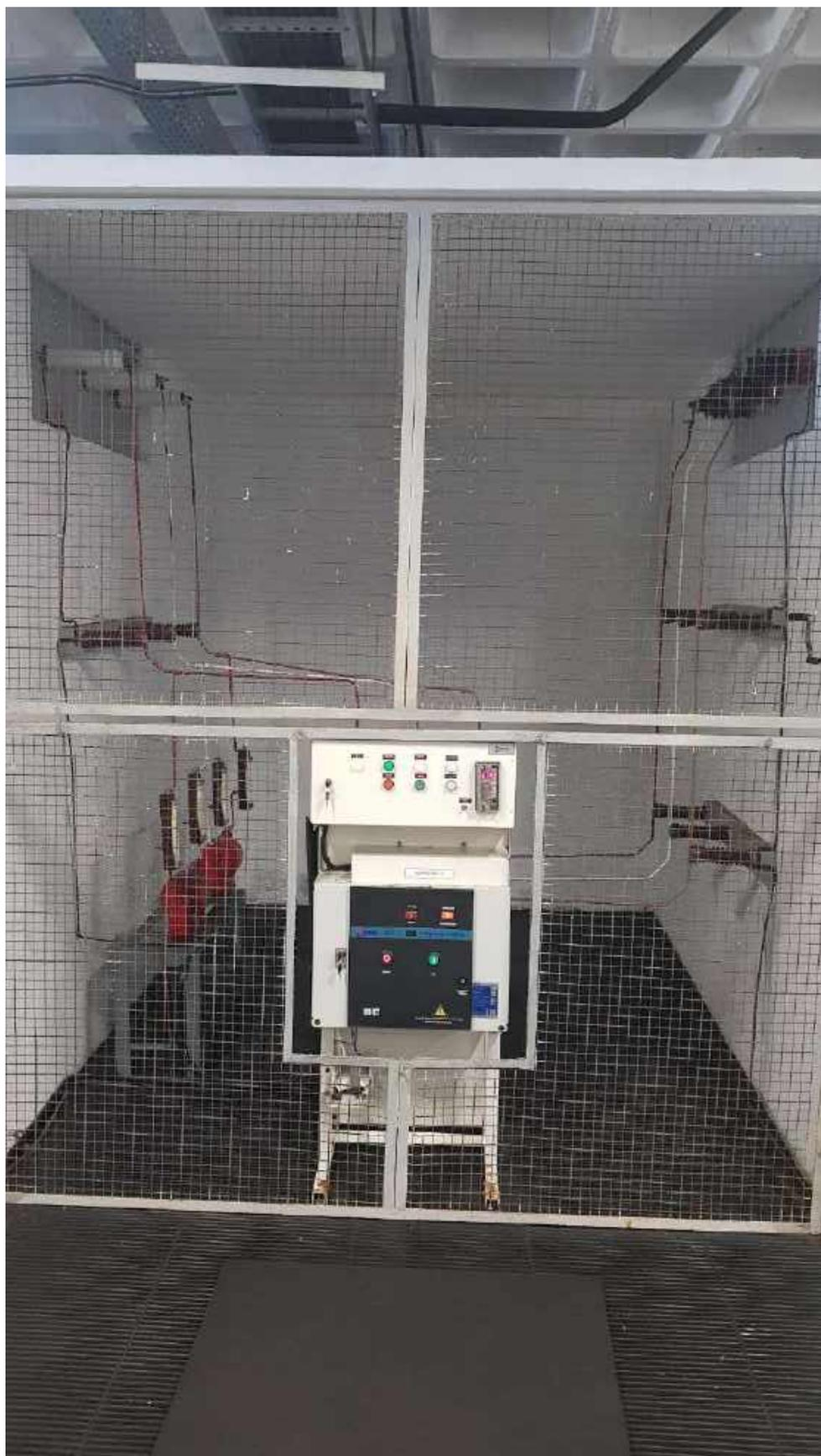
*Figura 8 - Disjuntor de média tensão da sub. do pav. Nísia.*
