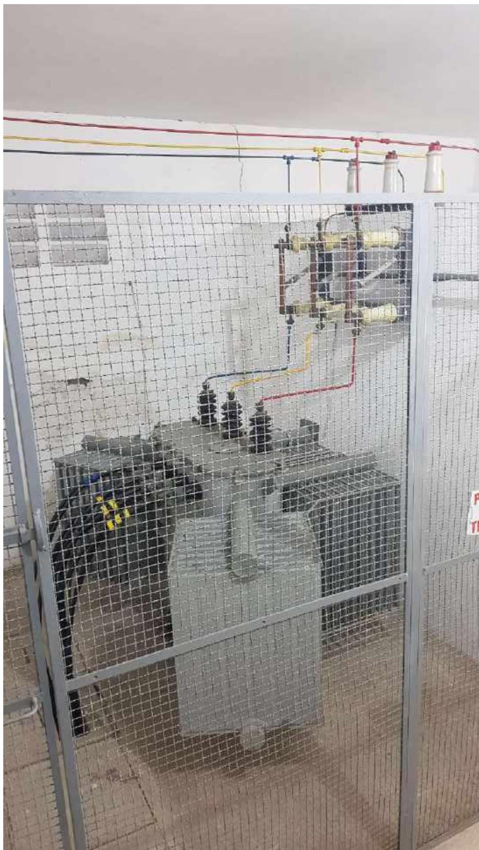
Figura 24 - Trafo de 500kvas do pav. Dunas.
