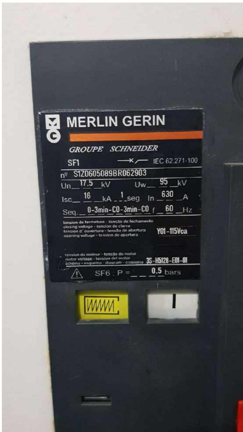
Figura 17 - Especificações do disjuntor de média tensão do pav. Morton.
