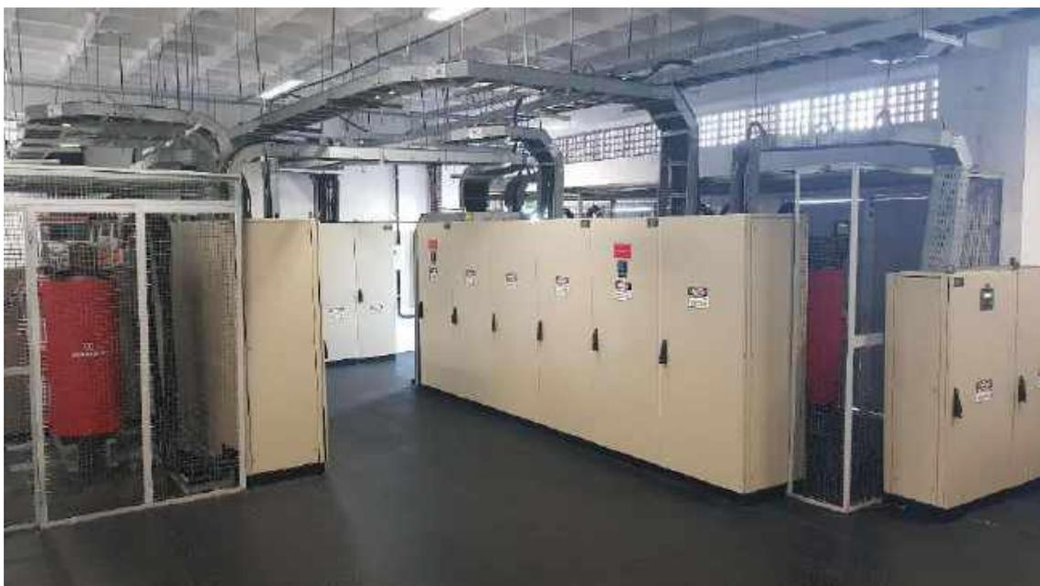
Figura 13 - Panorama geral e QGBTs da sub. do pav. Nísia.
