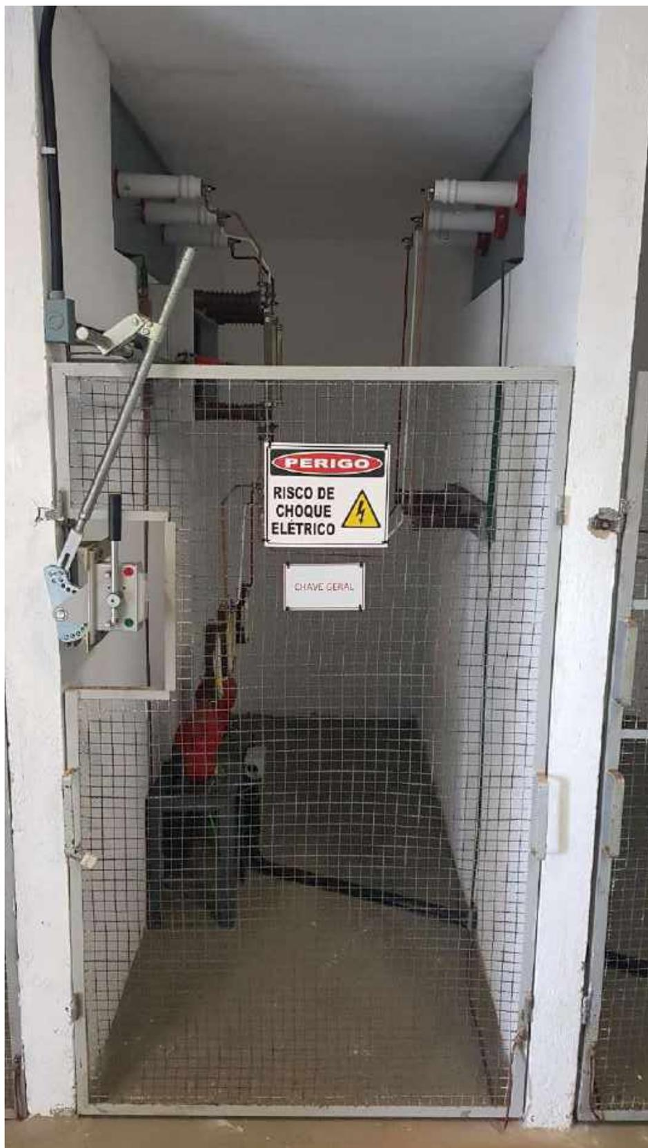
Figura 2 - Chave Seccionadora Geral do CCN.
