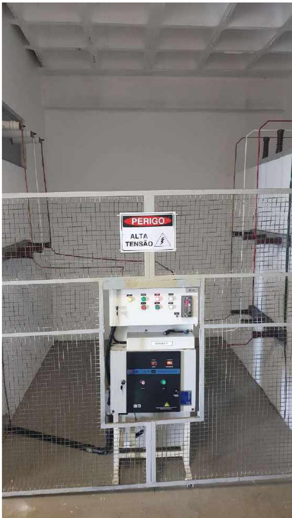
*Figura 3 - Disjuntor geral de média tensão do CCN.*
