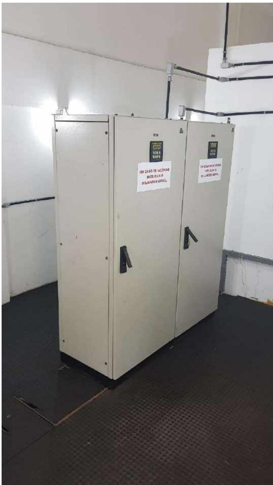
Figura 20 - QGBTs da sub. do pav. Morton.
