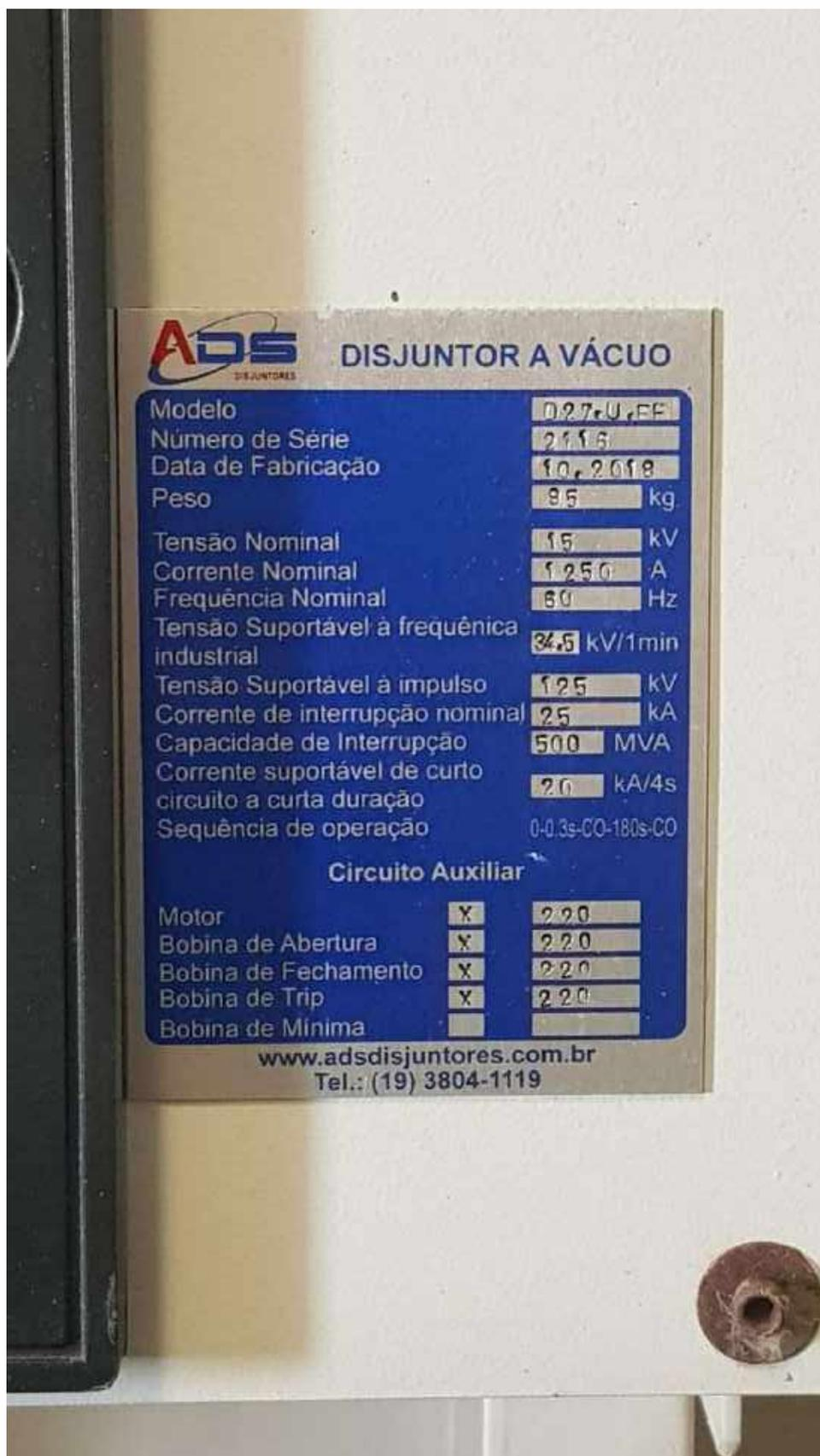
Figura 6 - Especificações de um dos disjuntores de média tensão da Sub. do Nísia.
