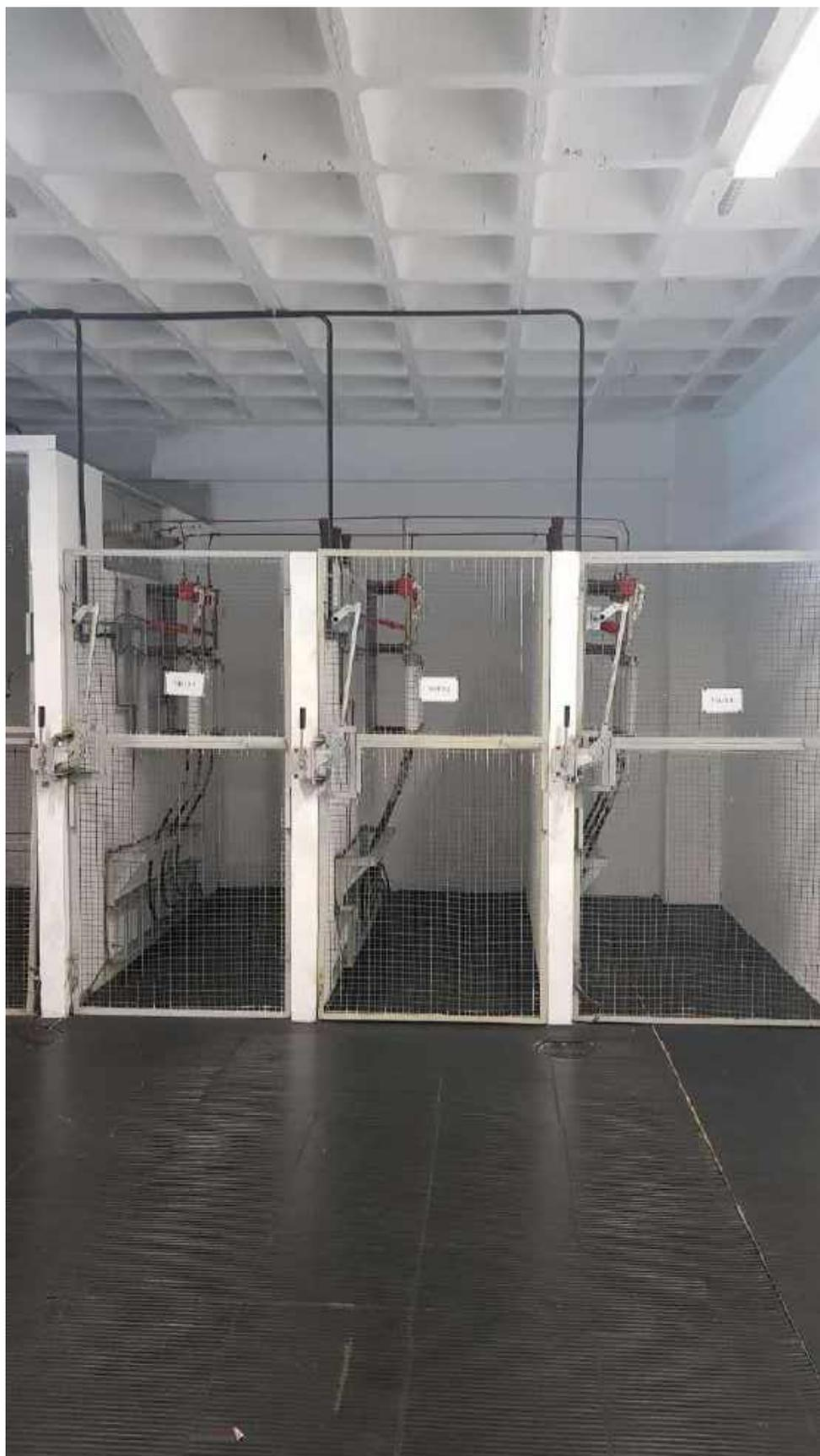
*Figura 9 - Chaves seccionadoras individuais para cada trafo.*
