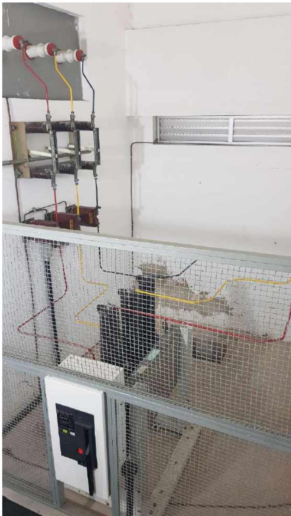
Figura 16 - Disjuntor de média tensão do pav. Morton.
