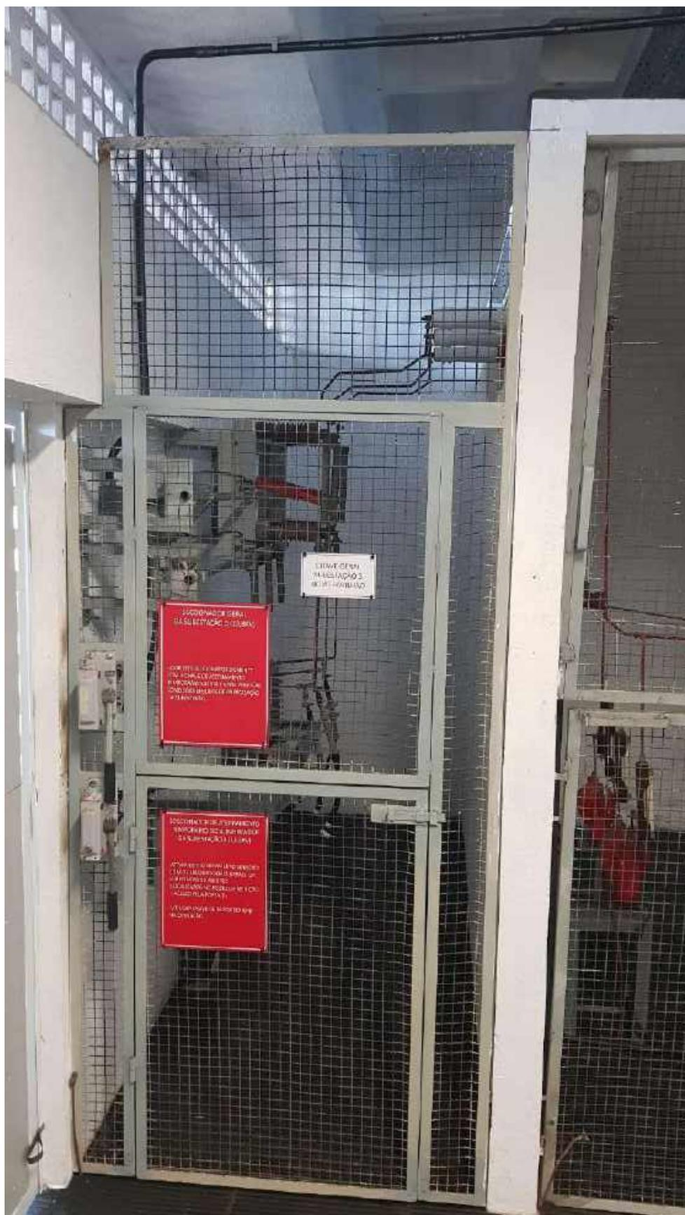
Figura 7 - Chave seccionadora secundária que alimenta a Sub. do pav. Nisia ou efetiva aterramento temporário.
