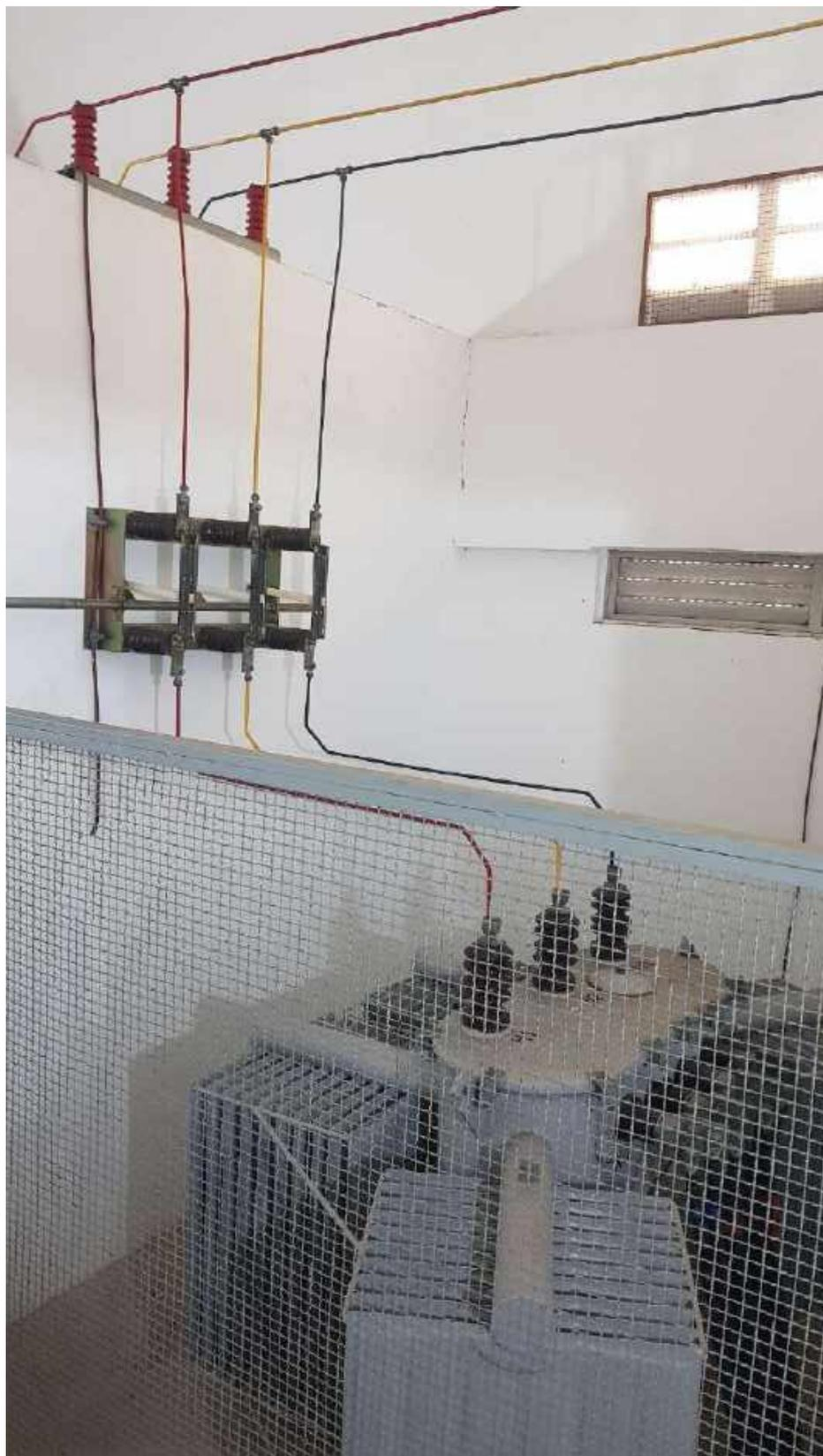
Figura 18 - Trafo de 500kvas do pav. Morton.
